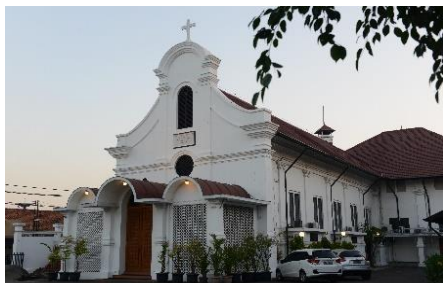
Gambar 15: Entrance pada Bangunan tambahan
