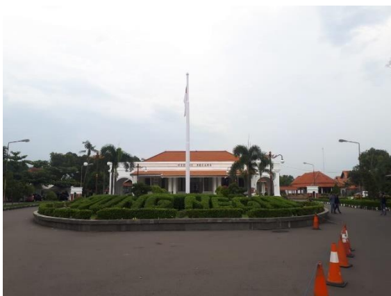
Gambar 2. Bangunan Gedung Negara Cirebon Sumber : Dokumen Penulis, 2020
