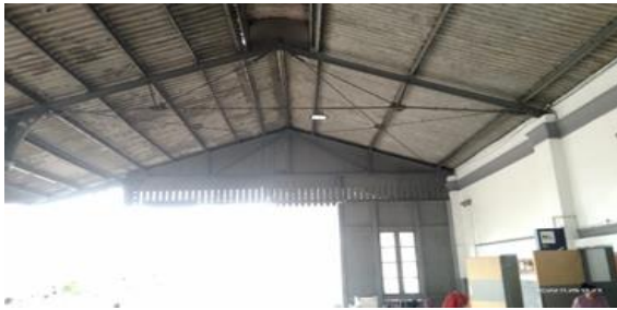
Gambar 11. Over capping dengan konstruksi atap baja dan penutup atap asbes sumber : dok penulis, 2023
