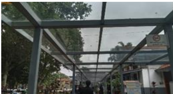
Gambar 5. Atap dengan penutup atap kaca sumber : dok penulis, 2023
