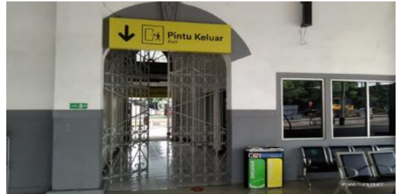
Gambar 15. Dinding sisi belakang bangunan sumber : dok penulis, 2023
