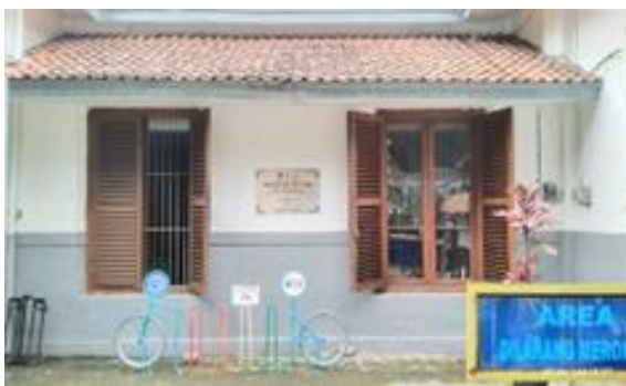
Gambar 6. Atap dengan penutup atap genteng tanah liat sumber : dok penulis, 2023
