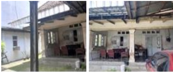
Gambar 18. Fasad Rumah Utama I Sumber : dok.penulis 2023
