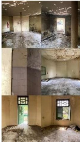
Gambar 6 : Ruang dalam Bangunan Bundar Kebumen Sumber : penulis, 2023
