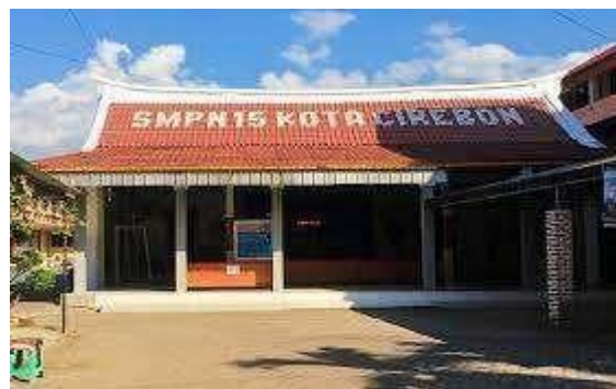
Gambar 2 : Gedung SMP 15 Cirebon Sumber : dok.penulis (2023)
