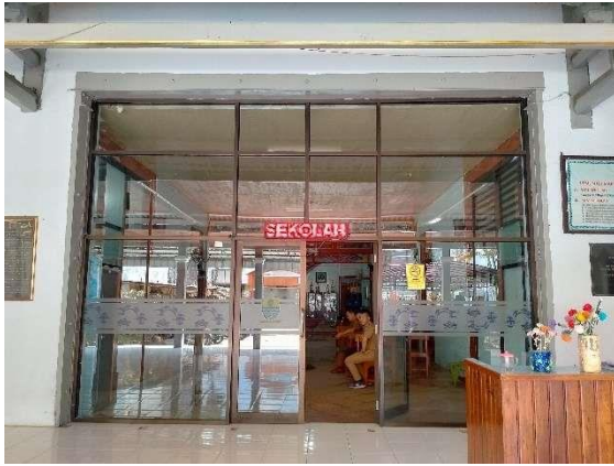
Gambar 14 : Pintu Utama pada bangunan SMPN 15 Sumber: penulis, 2023
