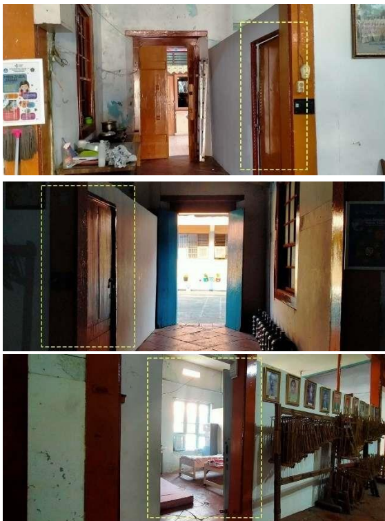
Gambar 15 : Penambahan pintu pada ruangan UKS dan Gudang pada bangunan SMPN 15 Sumber: penulis, 2023
