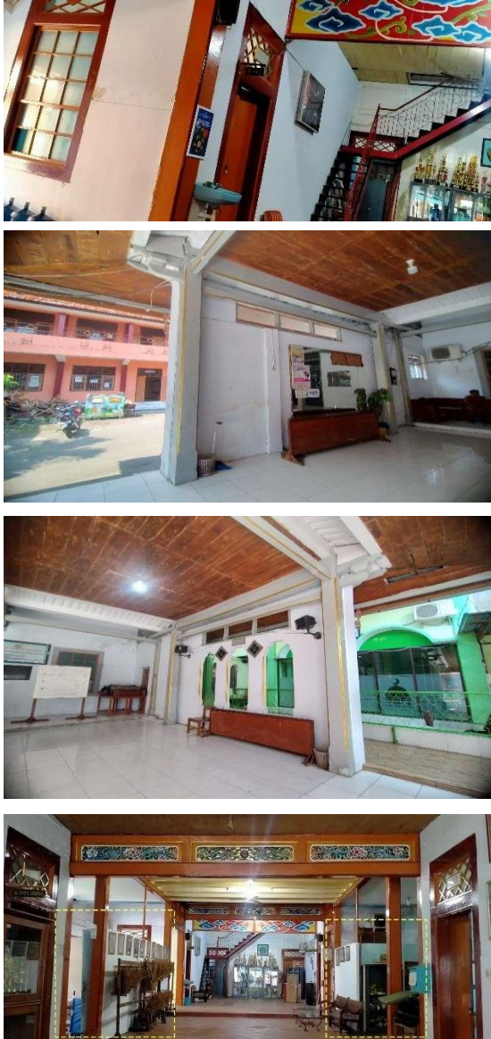
Gambar 12 : Penambahan dinding pada bangunan SMPN 15 Kota Cirebon Sumber: penulis, 2023
