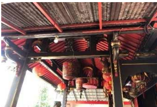
Gambar 8. konstruksi atap bangunan klenteng jamblang (Sumber : Penulis, 2023)
