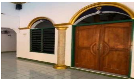
Gambar 30. menggunakan kusen kayu (Sumber : Penulis, 2023)
