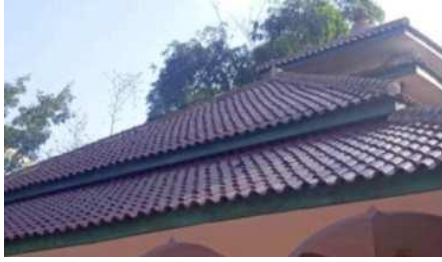
Gambar 27. genteng penutup atap menggunakan tanah liat (Sumber : Penulis, 2023)
