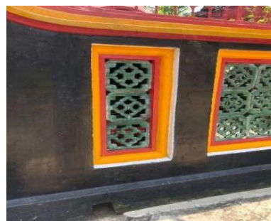
Gambar 13. dinding pagar klenteng menggunakan roaster keramik. (Sumber : Penulis, 2023)
