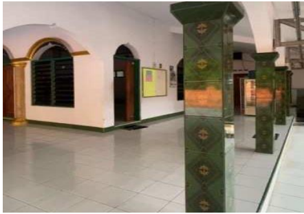
Gambar 28. menggunakan keramik bermotif pada kolom bangunan (Sumber : Penulis, 2023)
