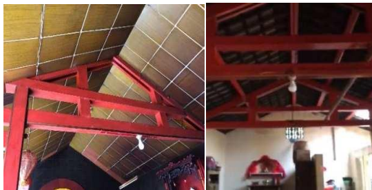
Gambar 12. konstruksi atap bangunan baru klenteng jamblang. (Sumber : Penulis, 2023)
