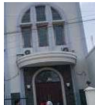
Gambar 36. apsis pada bangunan gereja (Sumber : Penulis, 2023)
