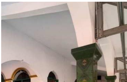
Gambar 29. menggunakan plafond grc (Sumber : Penulis, 2023)
