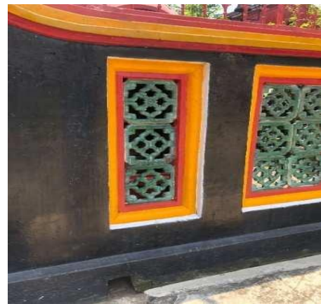
Gambar 10. pagar depan bangunan klenteng jamblang. (Sumber : Penulis, 2023)
