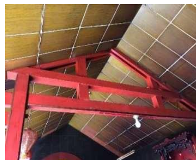
Gambar 14. penggunaan kayu pada konstruksi atap (Sumber : Penulis, 2023)
