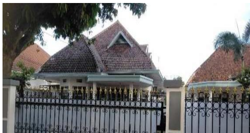
Gambar 8. Atap Bangunan Rumah Tinggal Samping LB LIA, Jl. Kesambi Raya, Cirebon.
