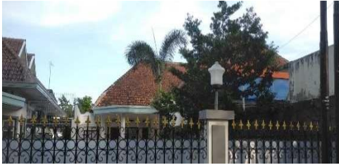
Gambar 7. Atap Bangunan LB LIA, Jl. Kesambi Raya No.83, Cirebon.
