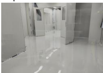
Gambar 13. Aplikasi Epoxy Top Coat Sumber : Dokumen Penulis, 2023
