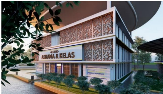
Gambar 6. Gedung Asrama dan Ruang Kelas Sumber: Analisa Penulis, 2024
