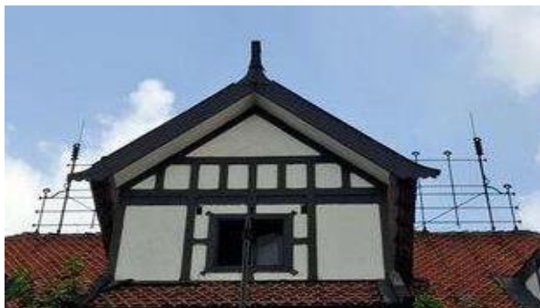
Gambar 4. Bagian Penutup Atap Gedung Singa Sumber : Pribadi, 2025
