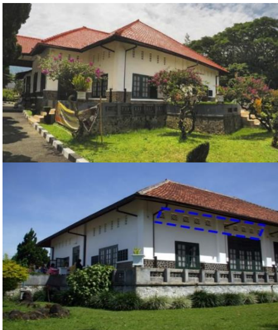
Gambar 8. Ventilasi Gedung Perundingan Linggarjati Sumber : Dokumentasi Pribadi, 2023
