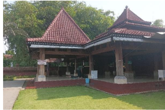
Gambar 3. Eksisting Masjid Al Karomah Sumber: Dokumentasi Pribadi (2026)
