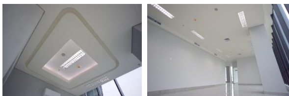
Gambar 9. Finishing Plafond (Sumber: Data Proyek, 2023)
