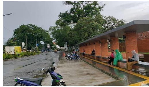
Gambar 9. Area Parkir Motor Sumber : Dokumentasi Penulis
