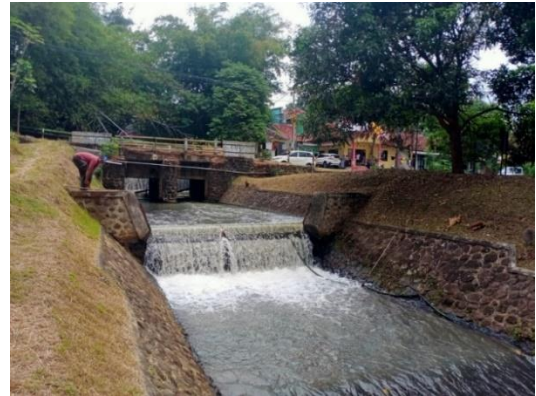
Gambar II-4: Bangunan Ukur Cipoletti
