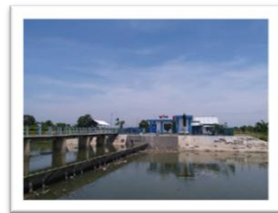
Gambar 3. Bendung Karet Berpelindung Baja (Obermeyer Crest Gate)
